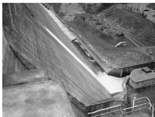
朝里ダム放水口
